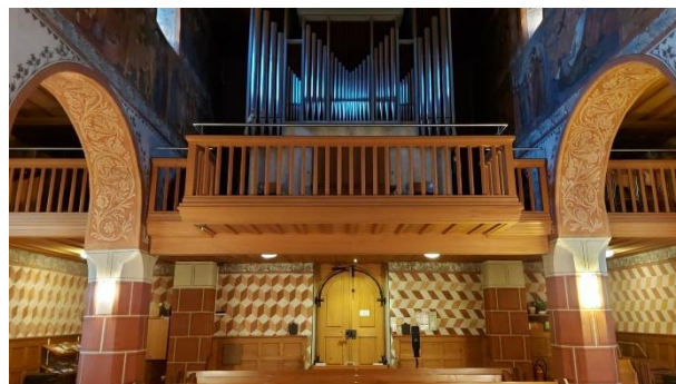
Auch das Geländer auf der Empore wurde auf 1 m ab Boden erhöht.
