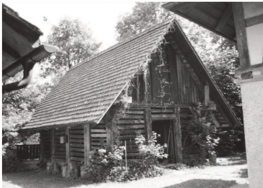
Abbildung 7 Schopf. Quelle Denkmalpflege
