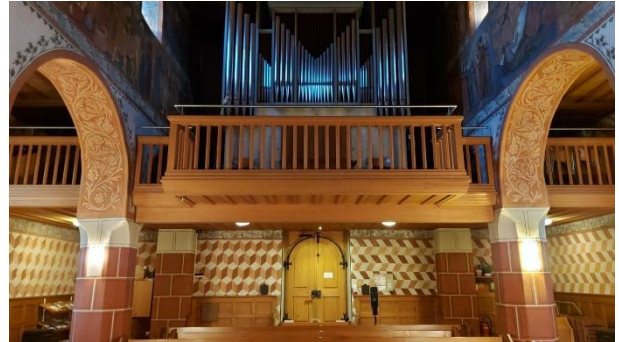
Auch das Geländer auf der Empore wurde auf 1 m ab Boden erhöht.
